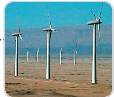
(شكل ٧) عدد (١٠٥) تيربينة رياح طراز Nordex N43، قدرة الوحدة ٦٠٠ ك.و. ثلاثية الريش، يبلغ قطر دوران الريش ٤٢ متر، مركبة على برج اسطواني بطول ٤٠ متر
