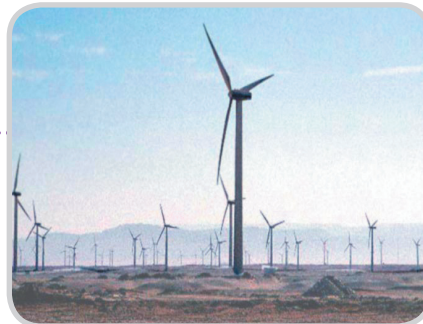
(شكل ٨) عدد (١١٧) تيربينة رياح طراز Vestas V47، قدرة الوحدة ٦٦٠ ك.و. ثلاثية الريش متغيرة الزاوية، يبلغ قطر دوران الريش ٤٧ متر مركبة على برج اسطواني بطول ٤٥ متر
