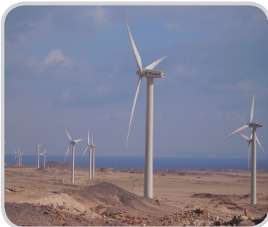
(شكل ٩) عدد (١٩٤) تيربينة رياح طراز Gamesa G52 قدرة الوحدة ٨٥٠ ك.و. ثلاثية الريش متغيرة الزاوية وسرعة الدوران، ويبلغ قطر الريشة ٥٢ متر، مركبة على برج اسطواني بطول ٤٥ متر
