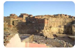
المناطق المهددة للحياة منطقة جبل المقطم منشأة ناصر - محافظة القاهرة
